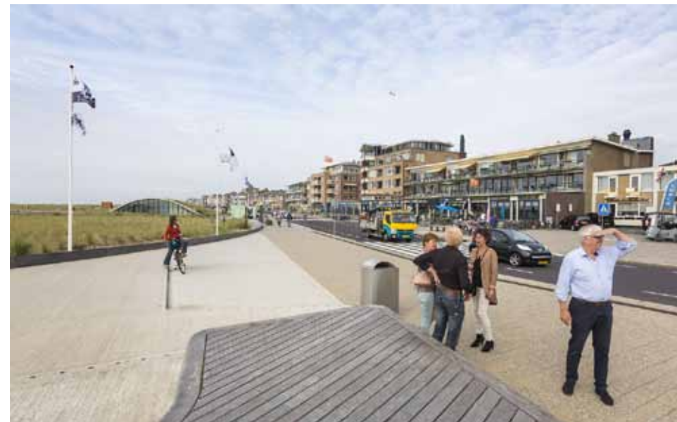
De nieuwe boulevard, op de achtergrond een entreegebouwtje voor de parkeergarage.
