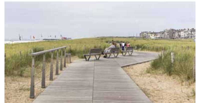
De kustversterking is aangeprepen om een glooiend duinlandschap te maken als geleidelijke overgang tussen het dorp en het strand. Boven De bouw van de bijzondere 'dijk-in-duin-constructie'. Onder het nieuwe duinlandschap ligt een parkeergarage.
